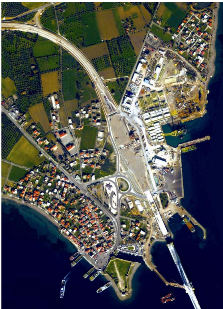
Χάρτης 9. Δορυφορική εικόνα της περιοχής του Αντιρρίου (Quickbird 3/11/03) όπου εμφανώς διακρίνεται και ο αναξιοποίητος χώρος του εργοταξίου κατασκευής της γέφυρας.
